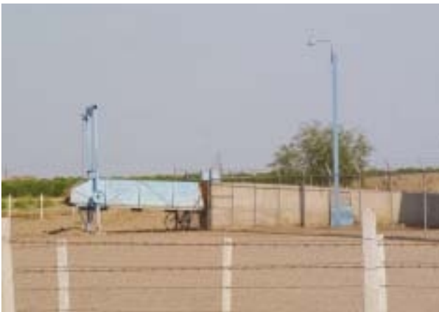
Rampa de carga
