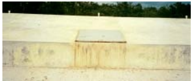
Pits de concreto
