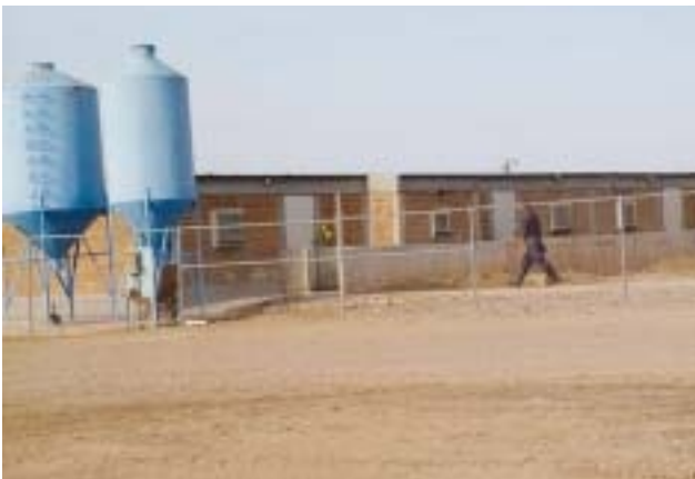
Pasillos de comunicación dentro de la granja
